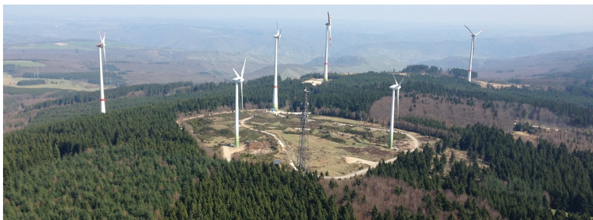
Abbildung 27: Windpark Kandrich auf ehemals militärisch genutztem Standort im Landkreis Bad Kreuznach (Rheinland-Pfalz)
