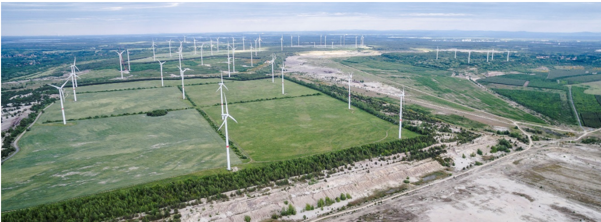
Abbildung 17: Repowerete Windenergieanlagen auf ehemaligen Tagebauflächen im Windpark Klettwitz, Landkreis Oberspreewald-Lausitz (Brandenburg)
